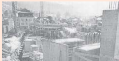
Das Bild zeigt den Stand der Arbeiten am Casino. Bild: Ernst Immoos
