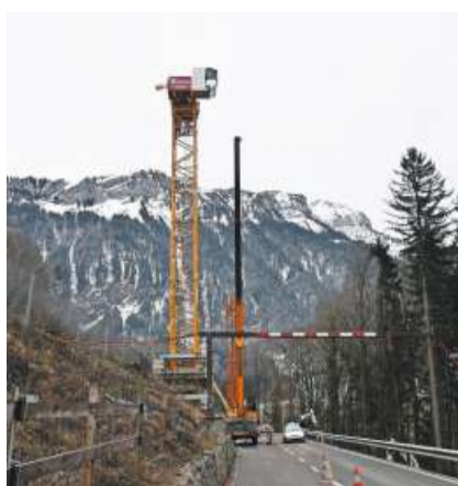
Am Gibelhorn wird der Kran abgebaut und die Strasse wieder freigegeben. Bild: Franz Steinegger
