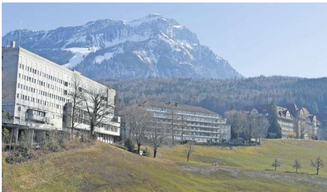
Das Kloster (links) und das Thesianum (rechts) bleiben bestehen, das Pflegeheim in der Mitte wird abgebrochen und versetzt. Bild: Silvia Camenzind
