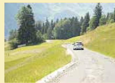
Die Haggeneggstrasse erhält den letzten Schliff. Bild Franz Steinegger
