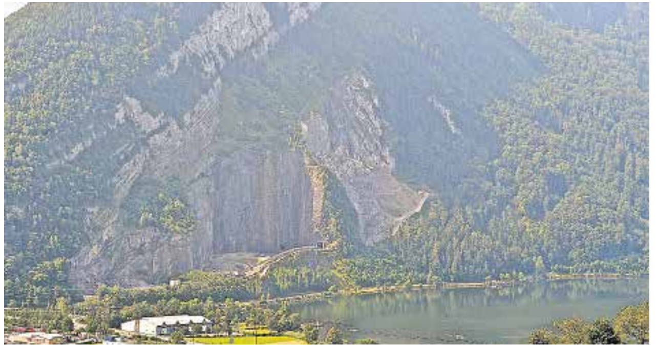
Der alte Steinbruch (links) wird mit Aushubmaterial aufgefüllt. Die Felsrippe zwischen ihm und dem jetzigen Abbaugelände bleibt bestehen. Die Erweiterung erfolgt Richtung Lauerz (rechte Bildhälfte). Bild Erhard Gick
