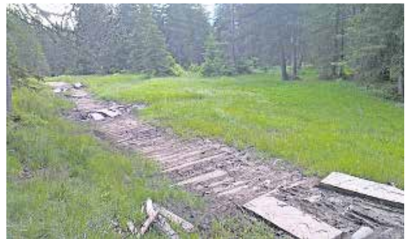
Das Bild spricht eine deutliche Sprache. Nässe hat dem historischen Prügelweg arg zugesetzt. Bilder OAK
