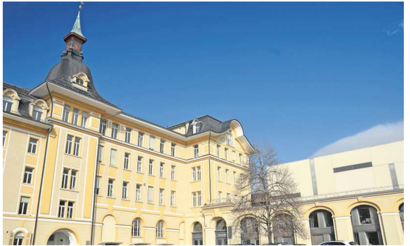
Aus der Turnhalle wurde das Staatsarchiv. Daneben sind weitere Verwaltungseinheiten tätig.
