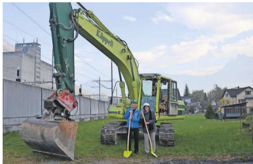
Der Ad-interim-Präsident der Baugenossenschaft, Markus Richner, und Gemeindepräsidentin Irène May-Betschart beim Spatenstich. Bild: Céline Reichmuth
