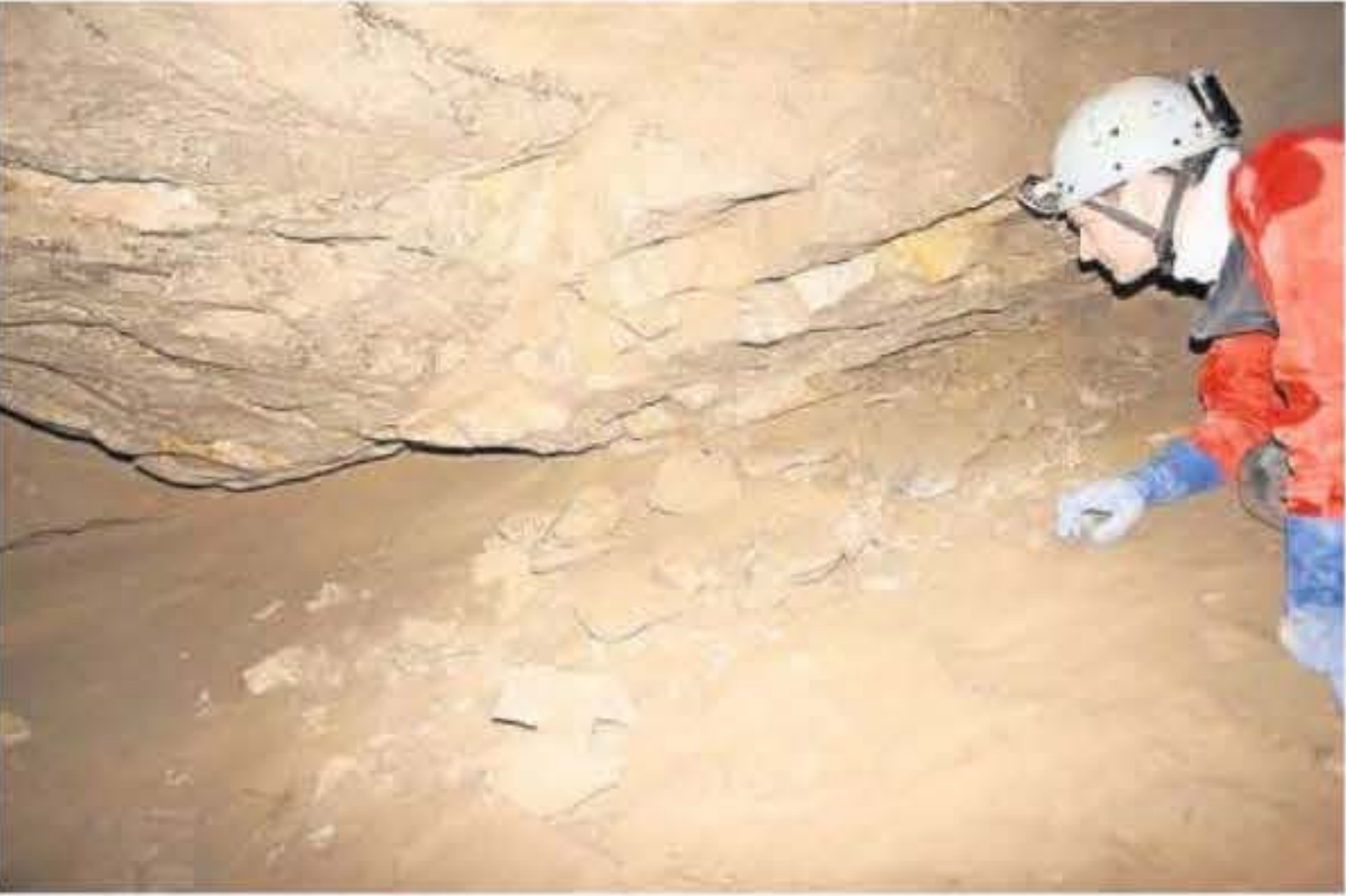
Rechts: An mehreren Orten im Hochsystem wurden abgeplatzte Steinplatten entdeckt, wie hier im Surseeingang. Bilder: AGH, A. Böke
